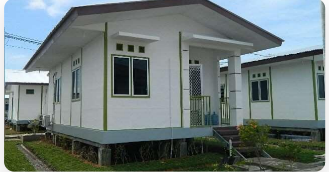
BANGUNAN JADI — RAPI & CEPAT HUNI
